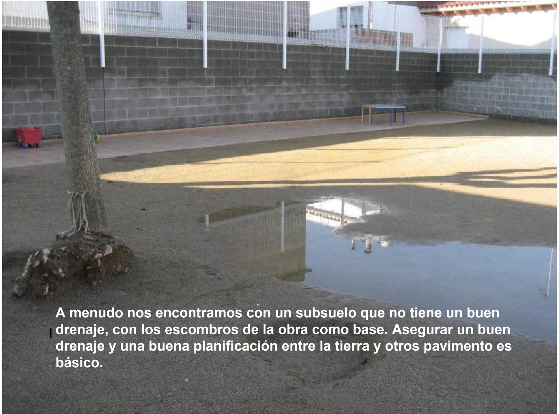
A menudo nos encontramos con un subsuelo que no tiene un buen drenaje, con los escombros de la obra como base. Asegurar un buen drenaje y una buena planificación entre la tierra y otros pavimento es básico.
